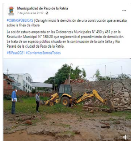
Figura 10. Demolición de construcción sobre la línea de ribera.
