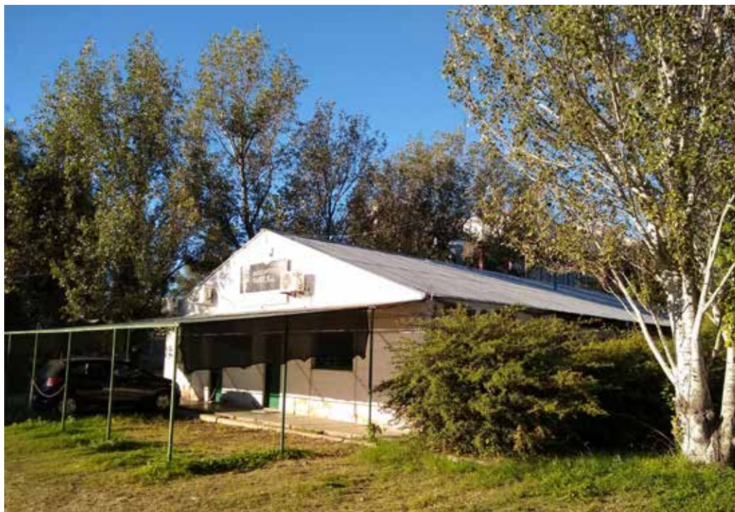
El ex obrador o “El galpón” es el lugar que se acondicionó en 1989 para Radio Universidad. Lugar en donde sigue funcionando la emisora universitaria. (Foto 2021).
