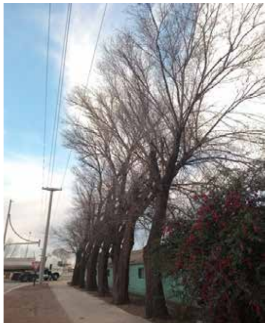
Figura N° 2: Olmos en Av. Mitre y colectora RN N° 7. Levantamiento de veredas, poco distanciamiento entre ejemplares, copa desbalanceada hacia la vivienda por la presencia de una línea de ½ tensión. El diámetro del tronco aún no llega a su máximo y ya se observa en un tamaño considerable. Ing. Agr. Cortez Miguel
