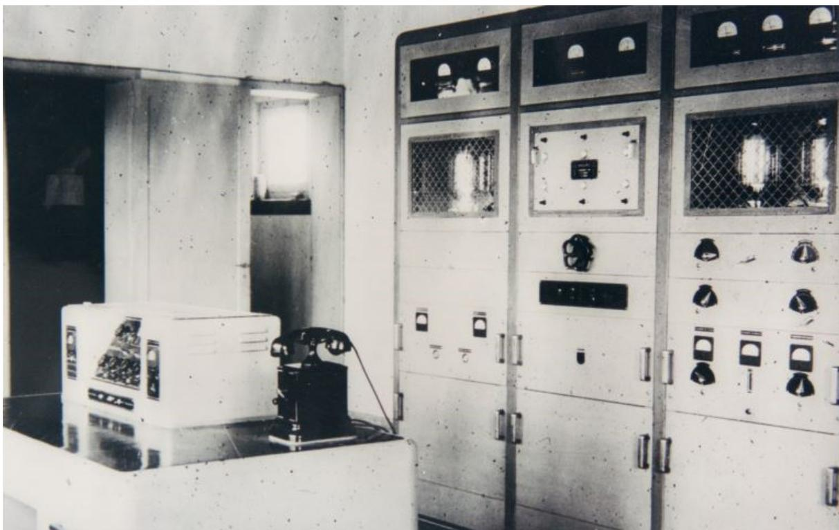
**Imagen N° 89** Equipo transmisor Phillips (derecha). Enlace y teléfono para coordinación con Estudios Centrales de calle Bolívar. Hacia 1944 (Archivo Toledo)
