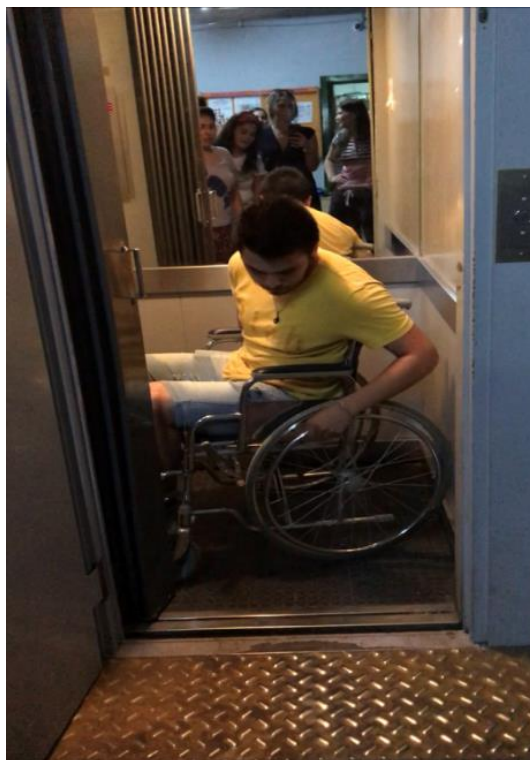
Ilustración 62. Joven en silla de ruedas dentro de un ascensor Tipo 1 (no permite el giro de la silla de ruedas ni la presencia de acompañante) 142 .
