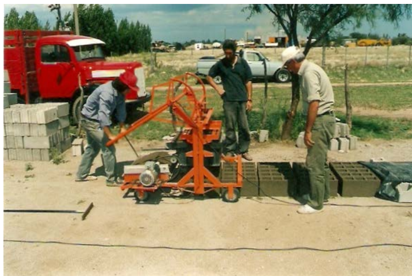
Vecinos haciendo los bloques
